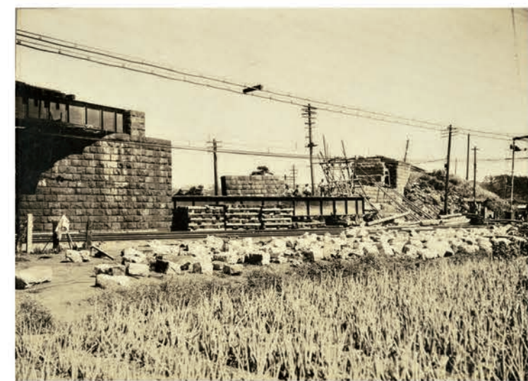
横浜線と東海道本線の交差点 鉄道連隊による復旧作業 前川謙三撮影 1923(大正12)年 横浜開港資料館所蔵
