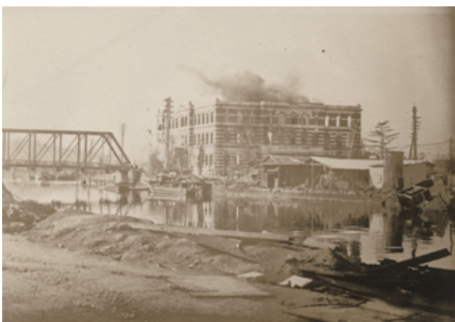
② 煙を上げる横浜市庁舎
