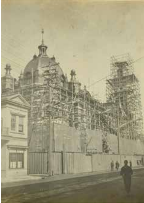
建設工事中の開港記念横浜会館 資料 5-1-2
