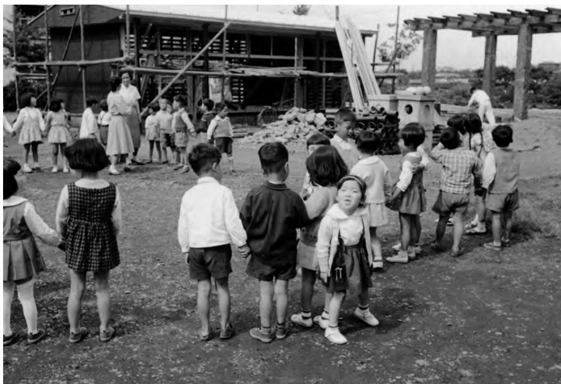
写真26 建設中のシェルター・ハウス
